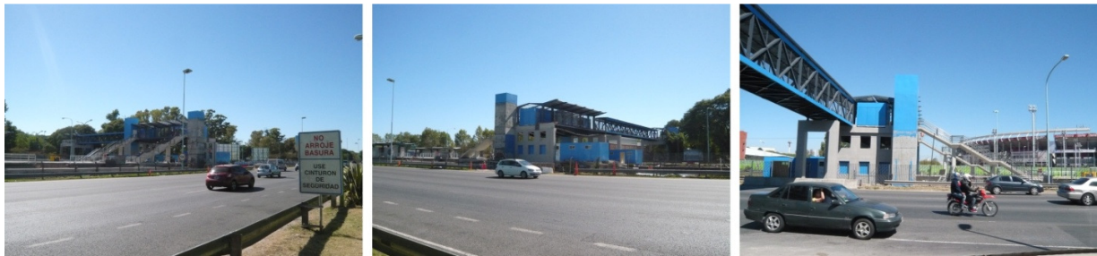
Figura 3. Construcción de la nueva Estación Ciudad Universitaria, 2015
